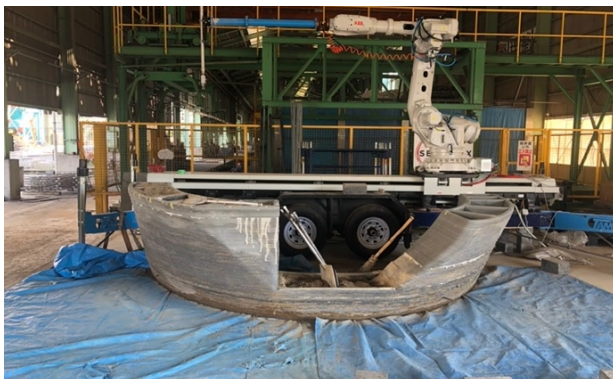
図 12. 実寸大型施工検証
