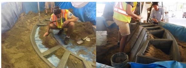
図 11. 砂をサポート材として使用する工法
